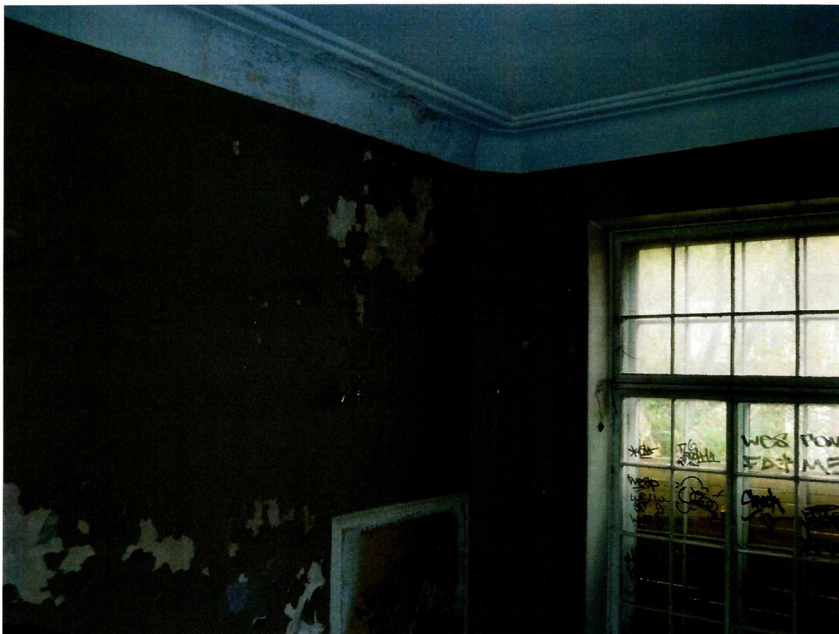
Фото № 4 от 16.10.2015. Внутреннее помещение.
