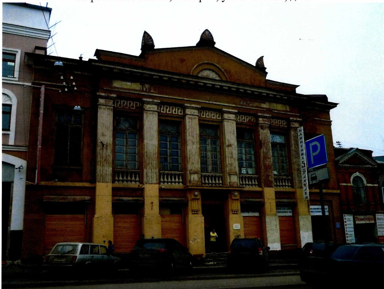
Фото № 1 от 16.10.2015. Главный уличный фасад.
