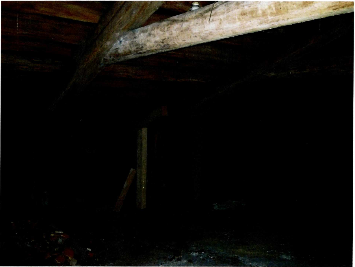
Фото № 8 от 16.10.2015. Чердачное помещение.
